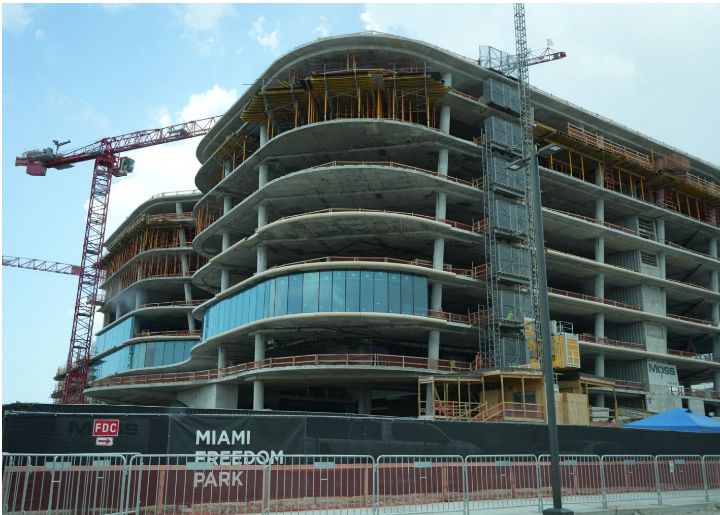
Nueva sede en construcción de la alcaldía en Miami Freedom Park. (FOTOS DANIEL CASTROPÉ)
